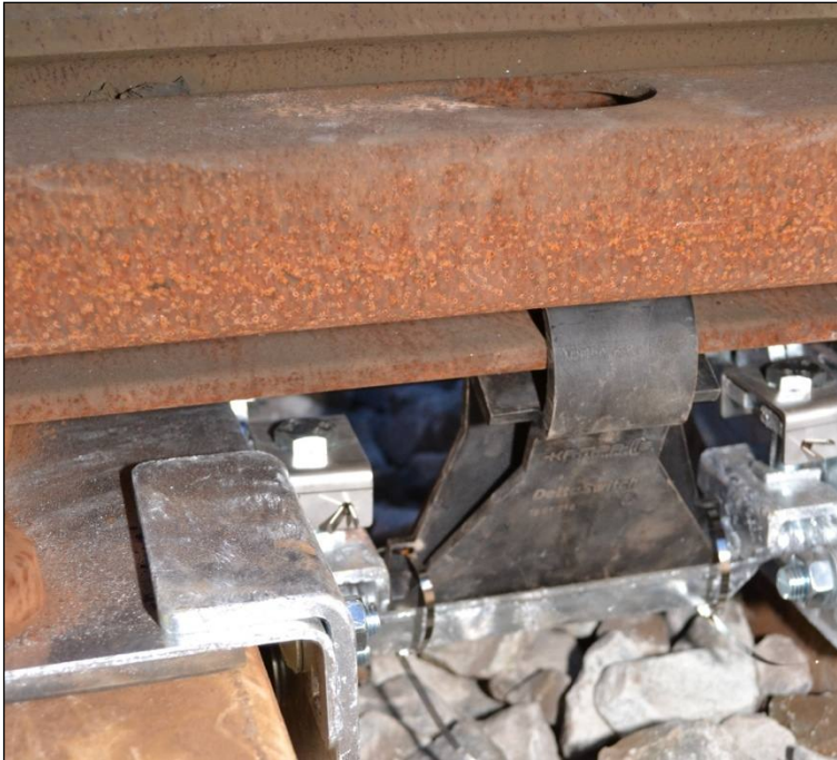
Afbeelding 12: DeltaSwitch pendelblok onder de tongverstijving (koker)
