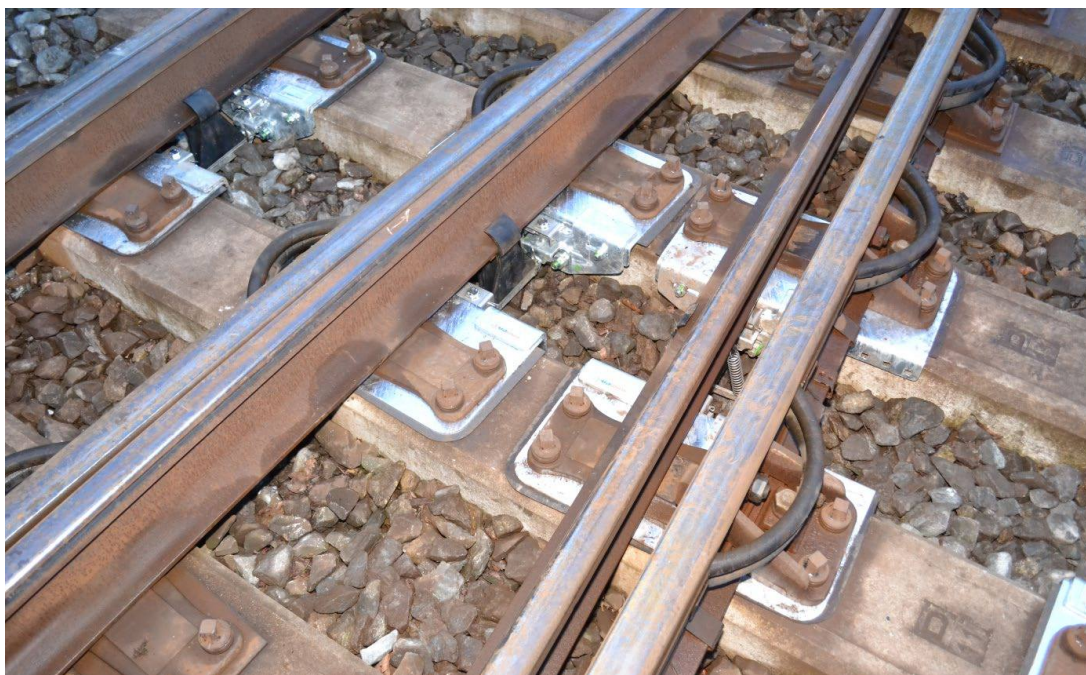
Afbeelding 13: DeltaSwitch in een Engels Wissel
