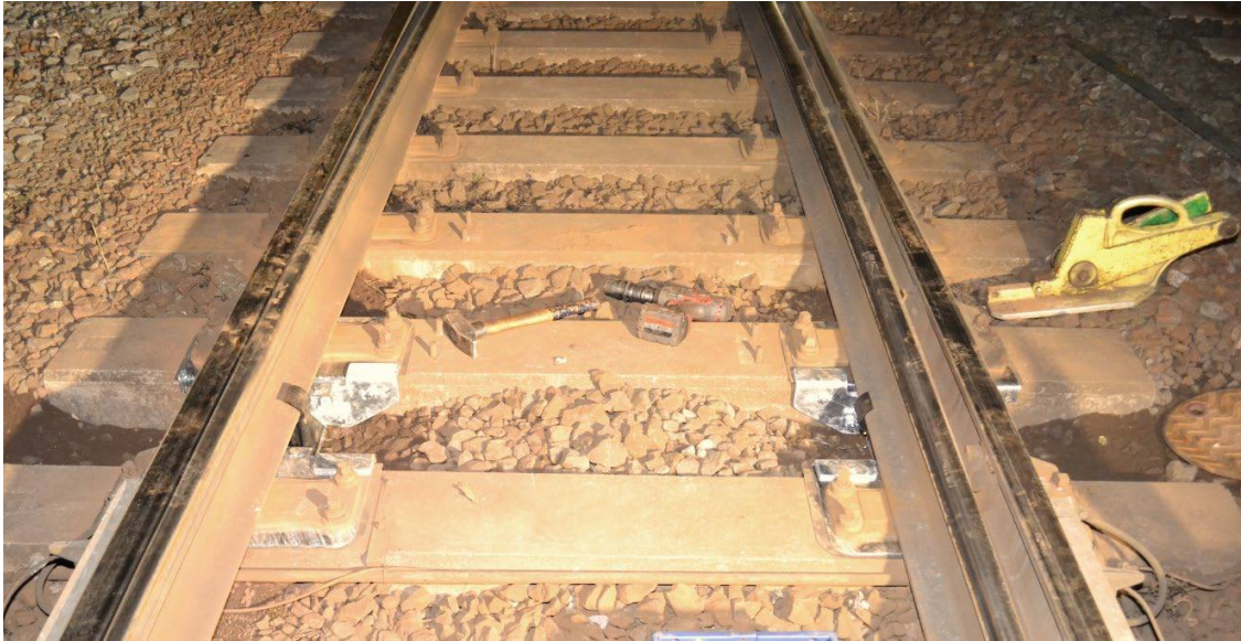
Afbeelding 5: Plaatsing spoorwiel in het liggervak achter de plaats waar het frame wordt ingebouwd
