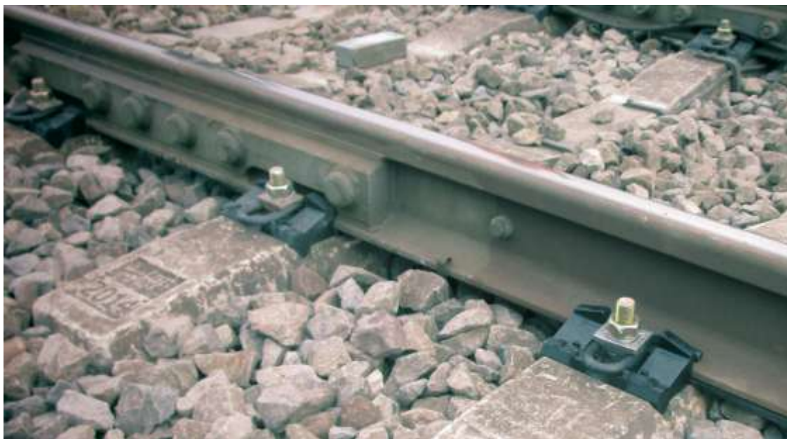
Afbeelding 20 ShimLift S op NS90 rond ES-lassen
