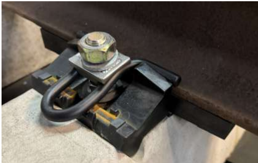
Afbeelding 14 ShimLift type S op een NS90 dwarsligger
