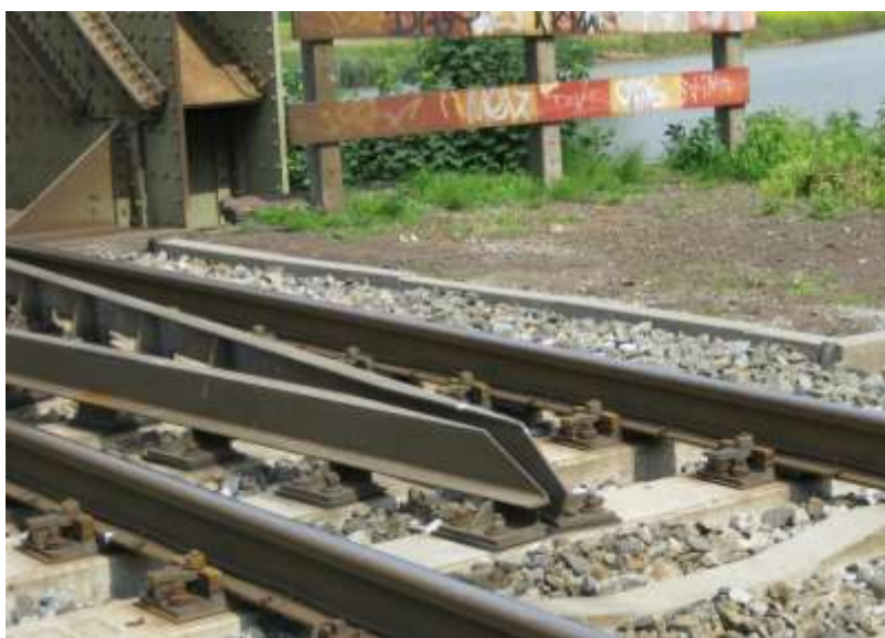
Afbeelding 21 Uitgevulde ontsporingsgeleiding
