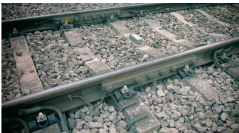
Afbeelding 22 ShimLift onder zwevend opgelegde ES-lassen
