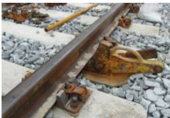
Afbeelding 9 Opgekrikte spoorstaaf
