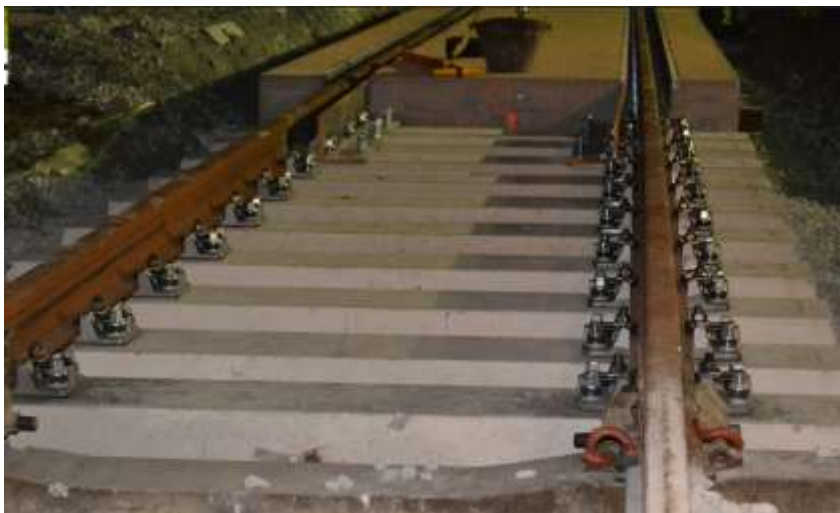
Afbeelding 7 Aanleg overgang met ShimLift bij vernieuwing
