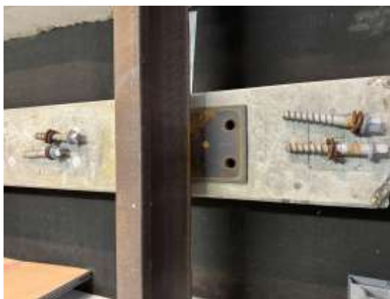
Afbeelding 10 Dwarsligger met onderlegplaat
