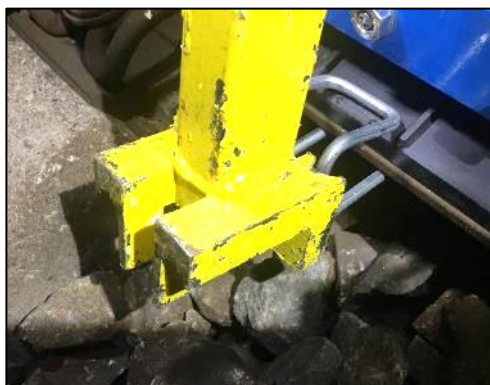
Figuur 12: Aandrukken van de veerklem
